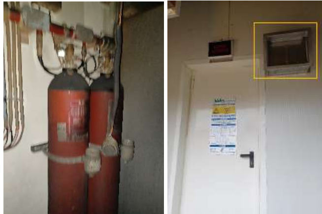
Figure 10 : Bouteilles de gaz inertant (2 x 80 L, gauche) et événement de surpression (droite)
