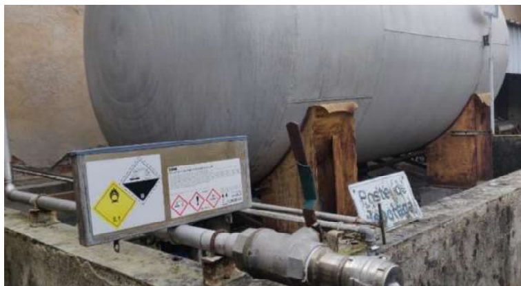
Figure n°5 : La cuve de peroxyde d'hydrogène avant l'explosion (Crédit HARTMANN EURO TF)
