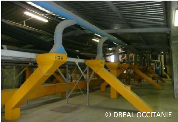
Aspiration de poussières sur un transporteur à bande et en tête d'un élévateur
