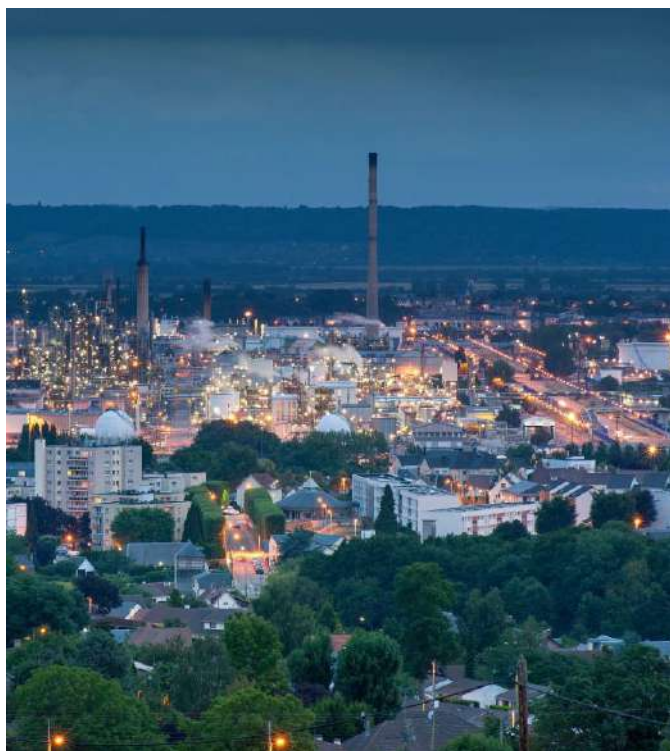
Figure n°1 : Vue du site (crédit EMCF)
