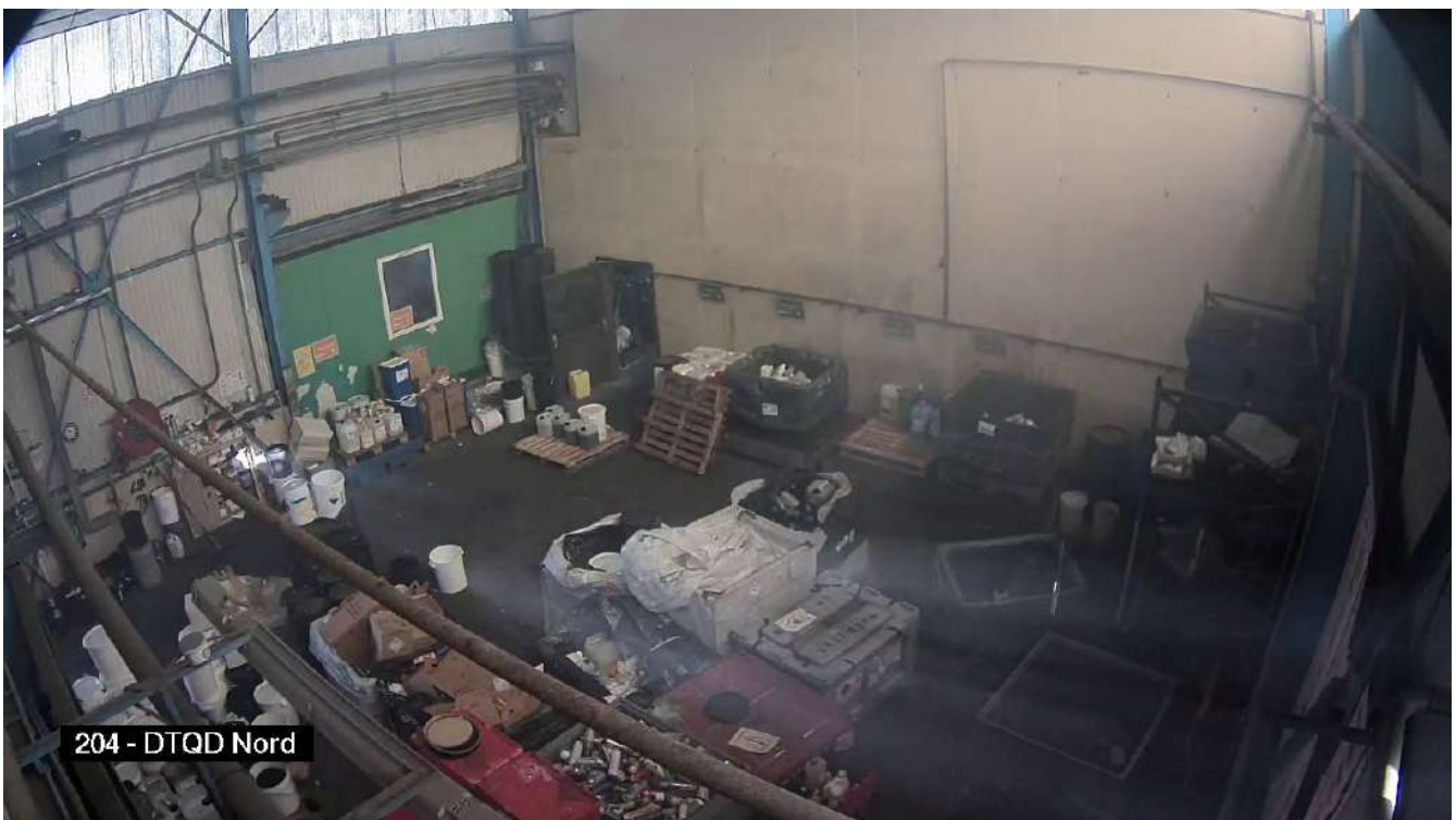
Photographie 11 : Vue du local DDD. Présence de fumée dans le faisceau de lumière (Crédits : Vidéo surveillance SPUR)
