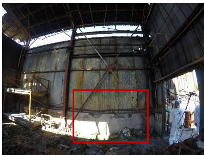
Photographie 16 : dégradations du béton à hauteur de la caisse de phytos
