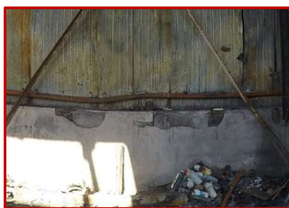
Photographie 16 : dégradations du béton à hauteur de la caisse de phytos
