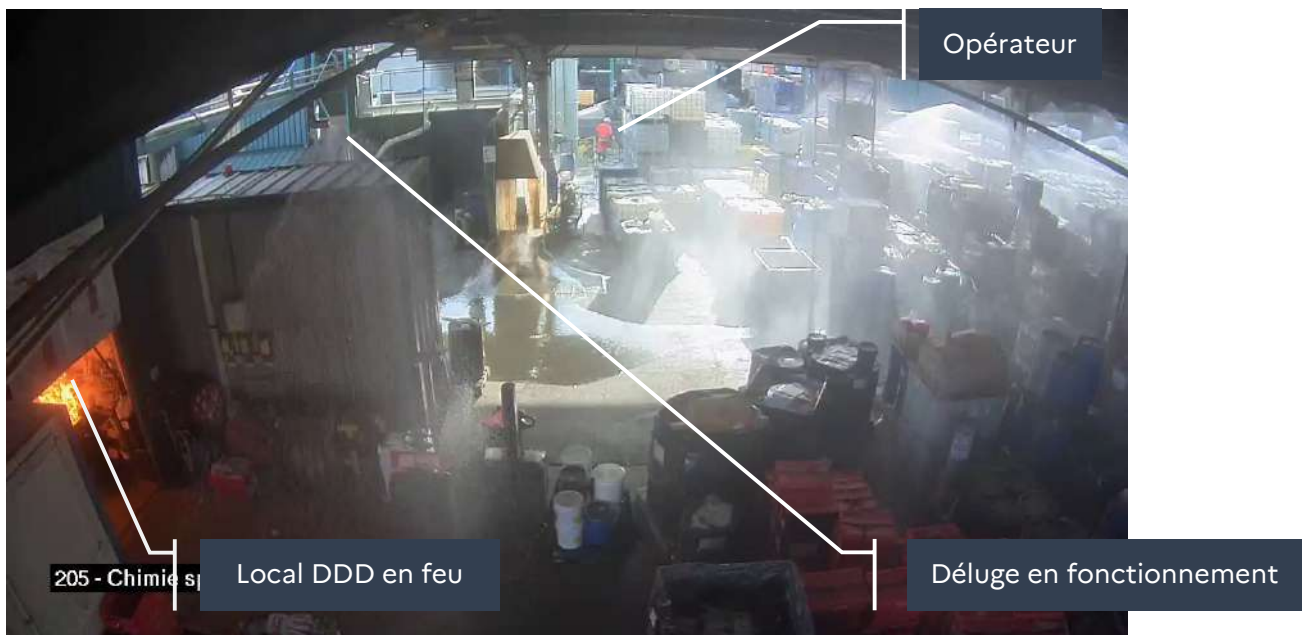
Photographie 18 : Image de la même caméra. Par rapport à la photographie précédente, on note que l'incendie a gagné en intensité, la quantité d'eau épandue a augmenté et le système d'extinction sous l'auvent s'est déclenché
