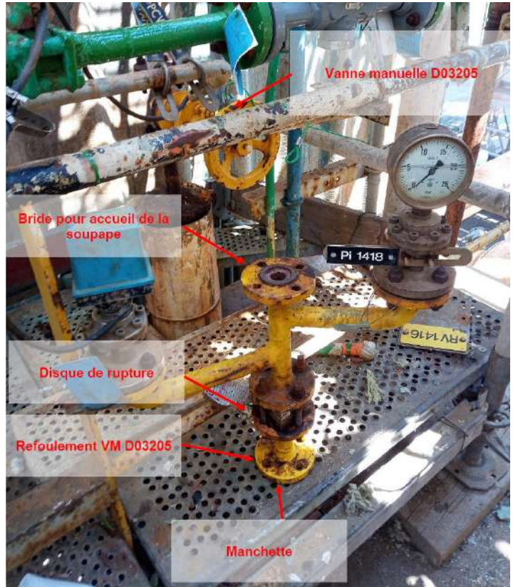
Photographie 3 : Photo du trident déposé (source KEM ONE)
