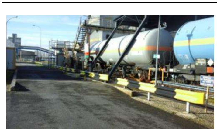
Figure 4 : Poste de déchargement des wagons-citernes dans le réservoir d'ammoniac anhydre (Crédit : LAT NITROGEN)
