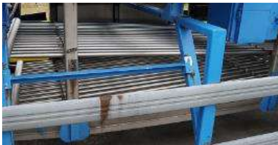
Figure 4 : Réchauffeur positionné sous la citerne
