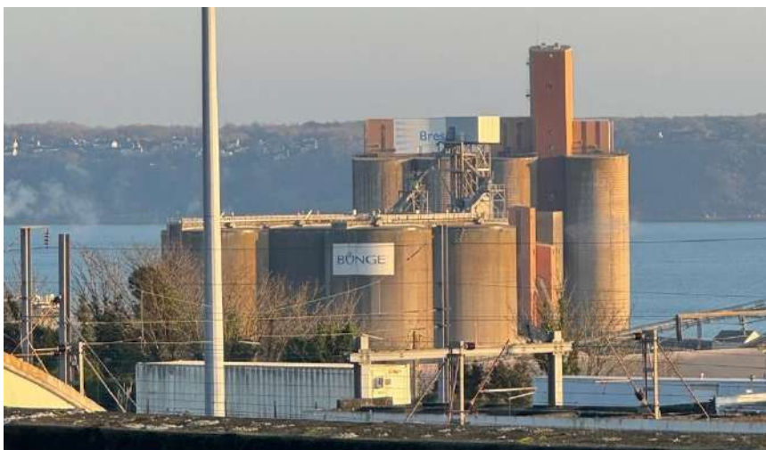
Figure n°1 : site BUNGE à Brest (29)
