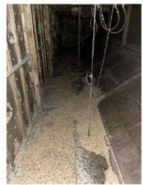
Figure n°6 : présence de coques dans la gaine « air usé » (crédit BUNGE)
