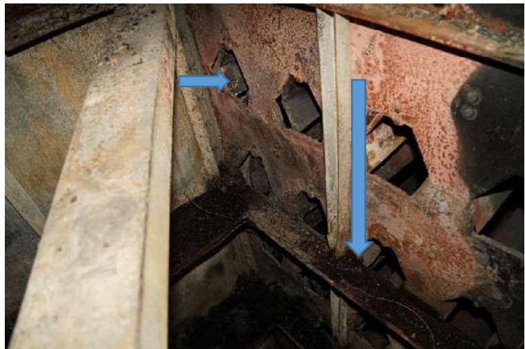
Figure n°10 : câble de la sonde (la trappe constituant le plancher est démontée)
