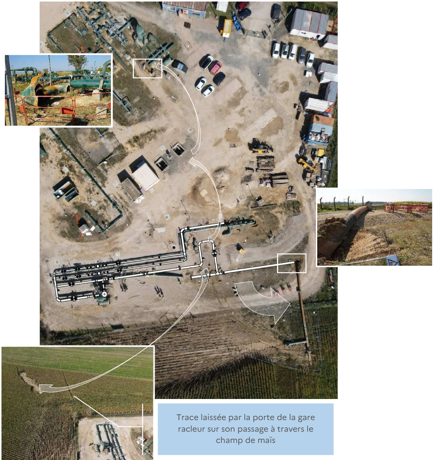
Photographie 6 : vue aérienne du site suite à l'explosion et description sommaire des traces principales de l'explosion
