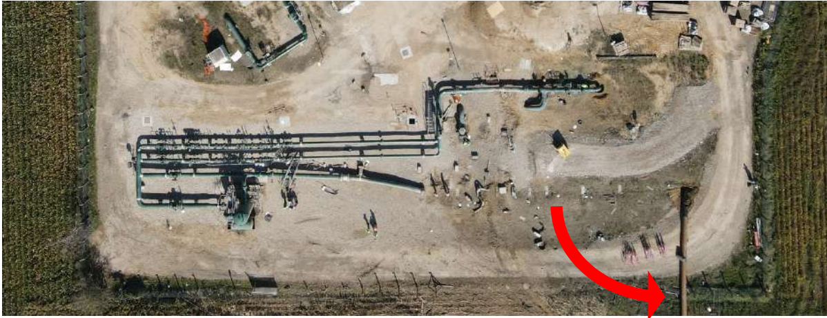
Figure 5 : Vue aérienne du pôle Etrez après l'explosion. La canalisation entre l'entrée du site et la gare racleur a pivoté de 90° (flèche rouge). La lyre n'est plus visible : elle s'est rompue en plusieurs points et a été projetée.
