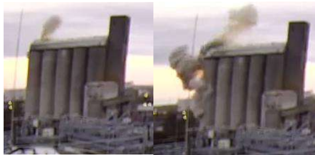
Figure 6 : Photos de l'accident prises par une caméra de surveillance d'un site industriel voisin, à quelques instants d'intervalle [photo transmise par le BEA-RI]
