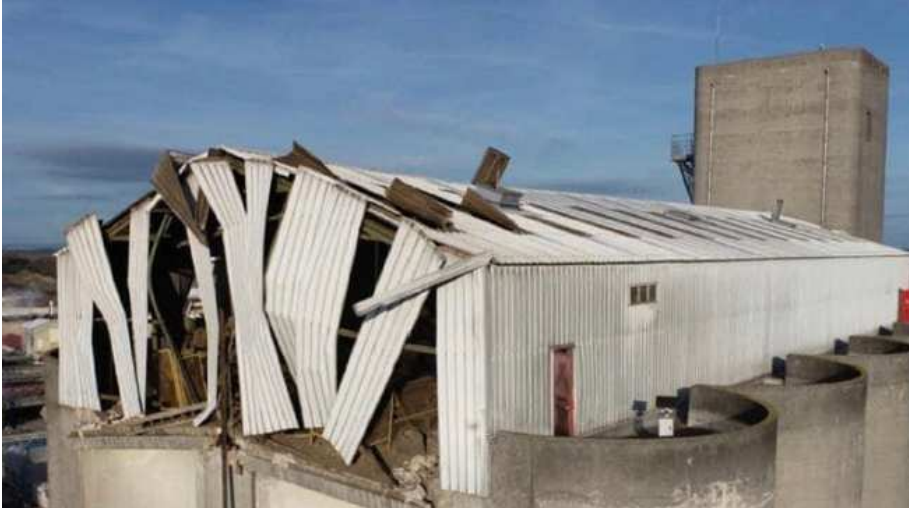
Photographie 1 : Vue de la partie supérieure du silo béton (Source : Cristal Union)
