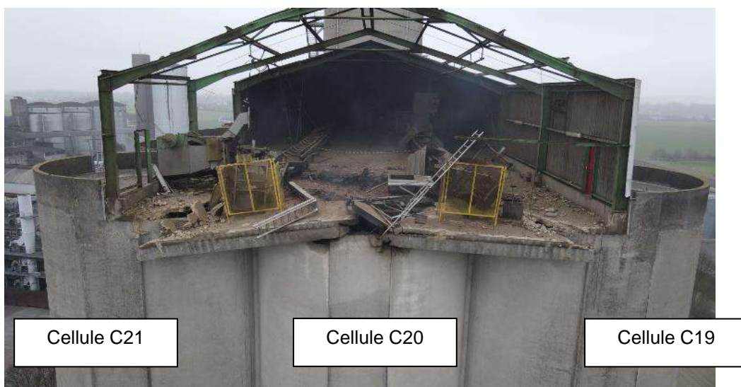
Figure 4 : Prise de vue du sommet du silo après l'accident du 06 janvier 2023 et le retrait des éléments de bardages de la galerie sur cellules [photo transmise par le BEA-RI]
