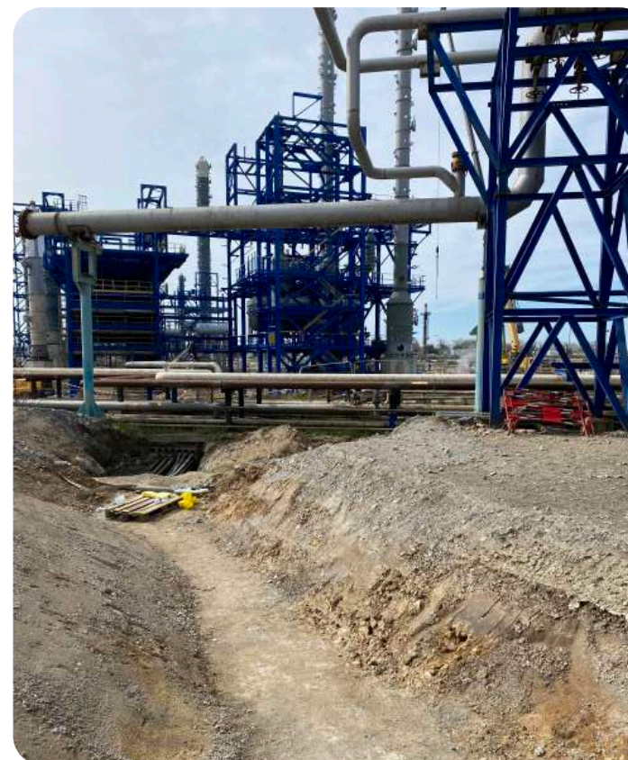
Sectionnement d'un câble d'alimentation électrique au sein de la raffinerie TotalEnergies de Donges (44).
