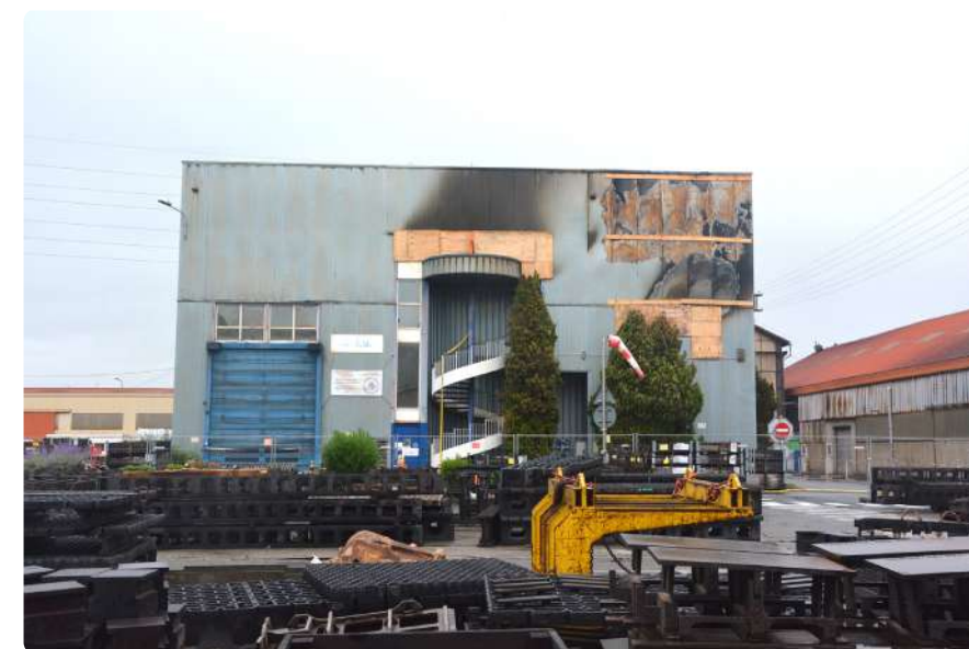
Incendie au sein d'un atelier de traitement de surface - Aubert et Duval - Pamiers (09).
