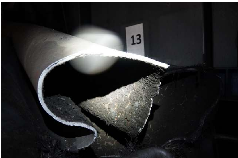
Émissaire de collecte des vapeurs de bains carbonisés et déformé (Aubert et Duval - Pamiers- 09).
