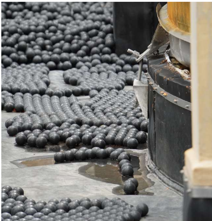
Fixation déformée du réservoir de stockage d'acide sulfonitrique (Manuco - Bergerac - 24).
