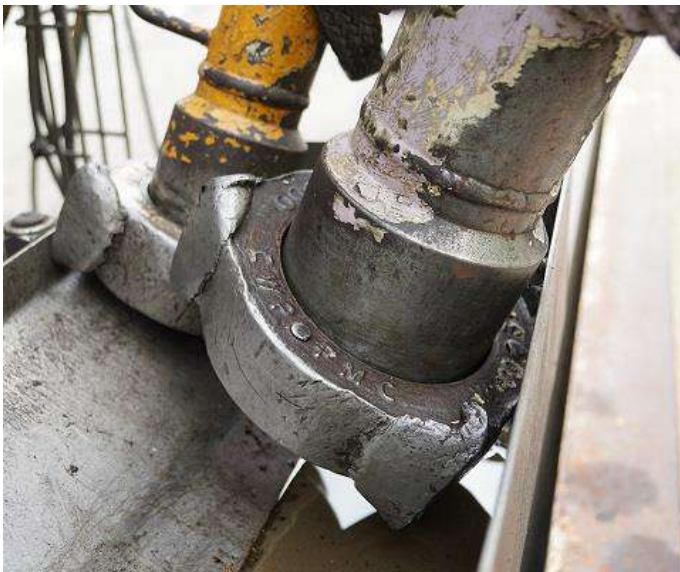
Photographie 3 : les oreilles de l'écrou à frapper sont de forme triangulaire et non parallélépipédique ce qui traduit une usure de l'écrou;
