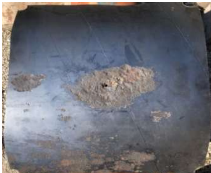
Figure 12 : P1 après enlèvement du brai et nettoyage
