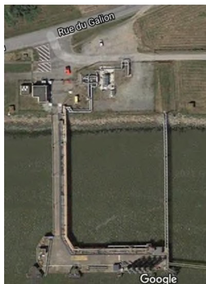
Figure 1 : Photo de l'appontement à proximité duquel les irisations sont observées (source Google Maps)
