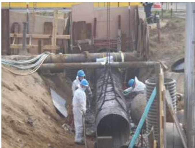
Figure 8 : Vue de l'extraction des tronçons de pipeline
