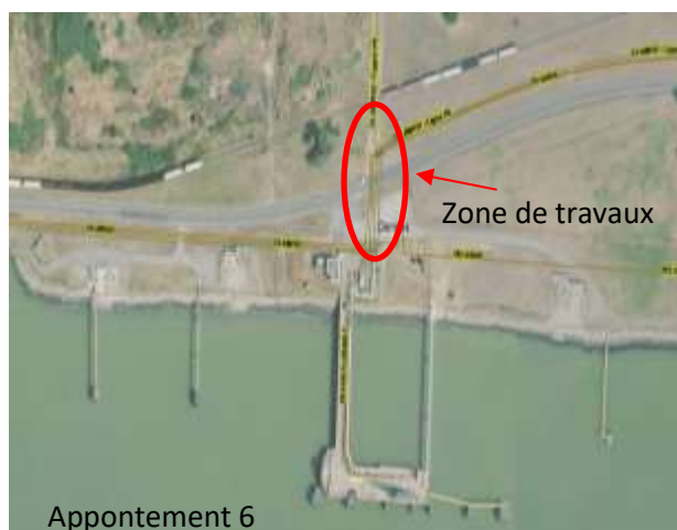
Figure 1 : Vue aérienne de la zone de travaux
