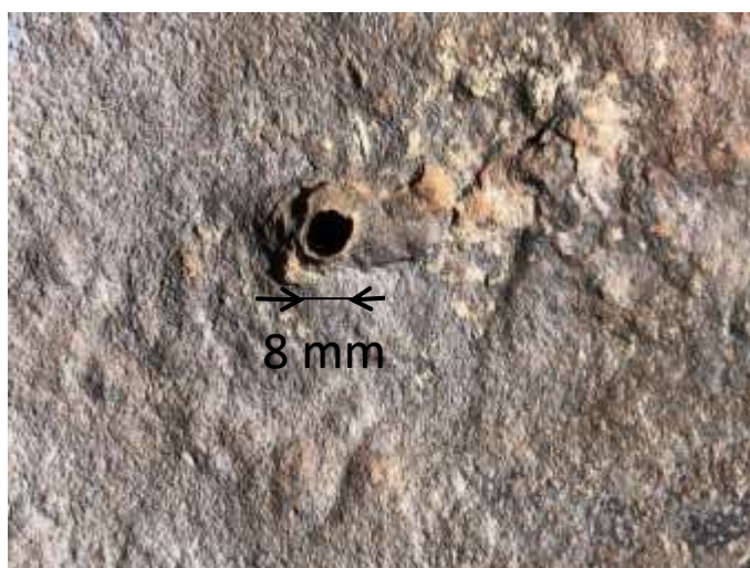
Figure 14 : Détail de la figure 13 - Vue du chemin de fuite-
