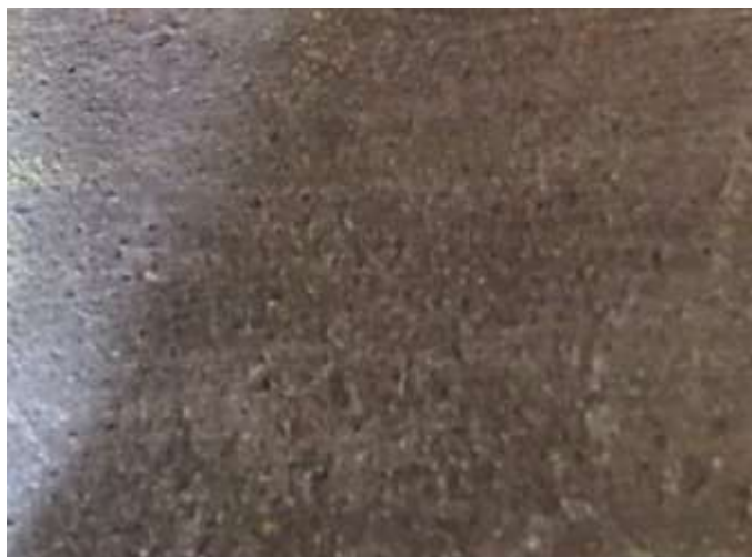
Figure 11 : Vue de la paroi intérieure (T9)
