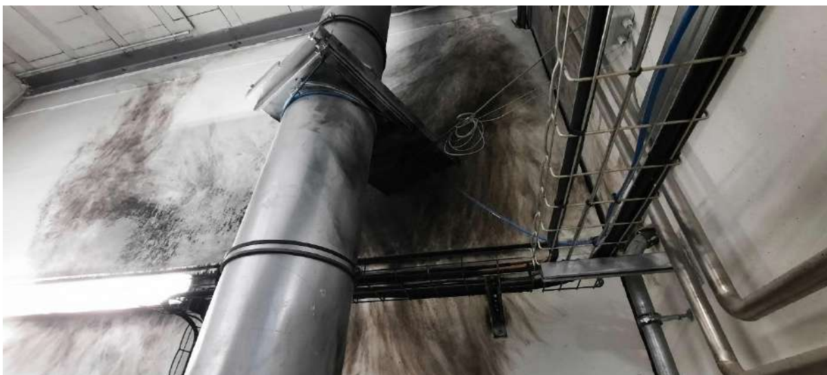
Figure 5 : Importantes traces de combustion dans le local broyeur, au niveau de la canalisation de sortie vers le cyclone
