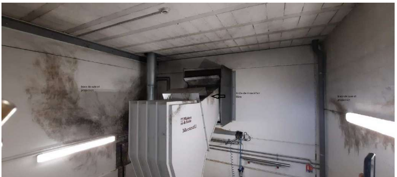
Figure 8 : projections observées dans le local broyeur
