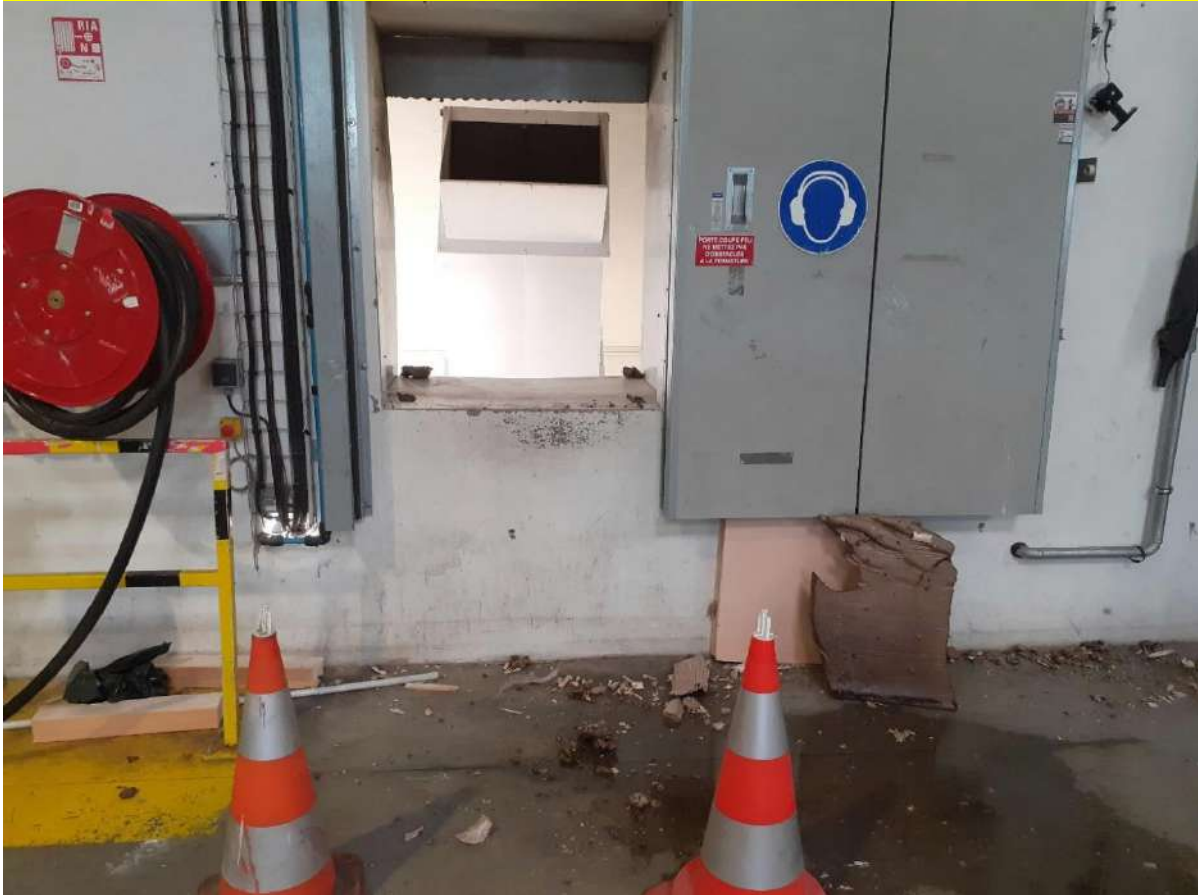
Figure 3 : Porte coulissante donnant accès à la bouche d'introduction des panneaux dans le broyeur
