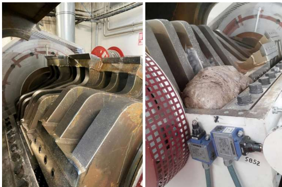
Figure 6 : Vue de l'intérieur du broyeur
