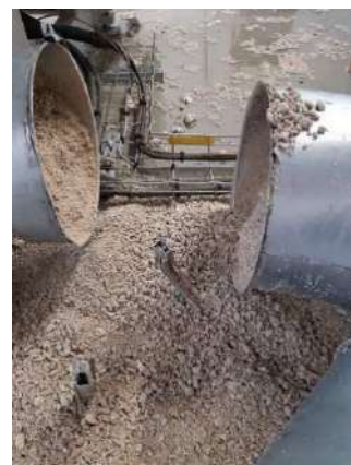
Figure 10 : canalisation de mise en dépression obstruée
