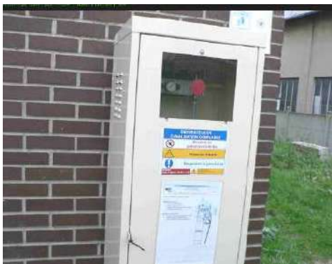
Figure 7 : Dispositif de rétention des eaux d'extinction au moyen de coussins pneumatiques gonflables
