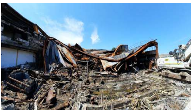
Photo 20 : Vue du local de galvanoplastie après sinistre
