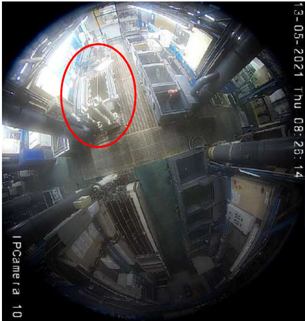
Photo 1 : 7h26 le 13 mai 2021, aucune présence de flamme ou fumées n'est visible autour du bain de cuivrage alcalin
