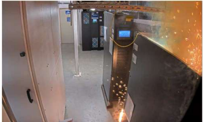
Photographie 7 : 0h35, départ de feu dans l'ASI2 (source : image extraite de la vidéosurveillance OVH)
