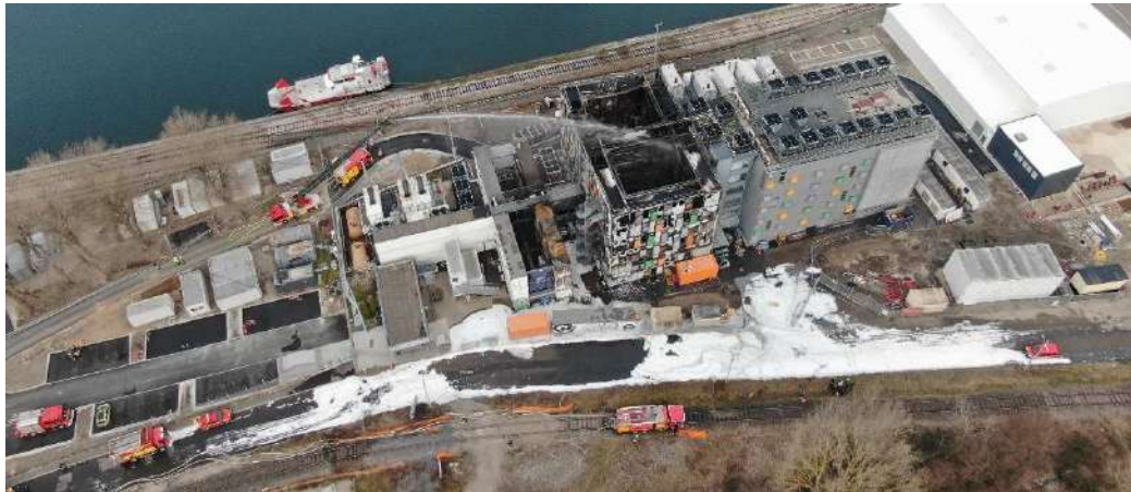
Photographie 2: site le lendemain de l'incendie (source SIS 67)
