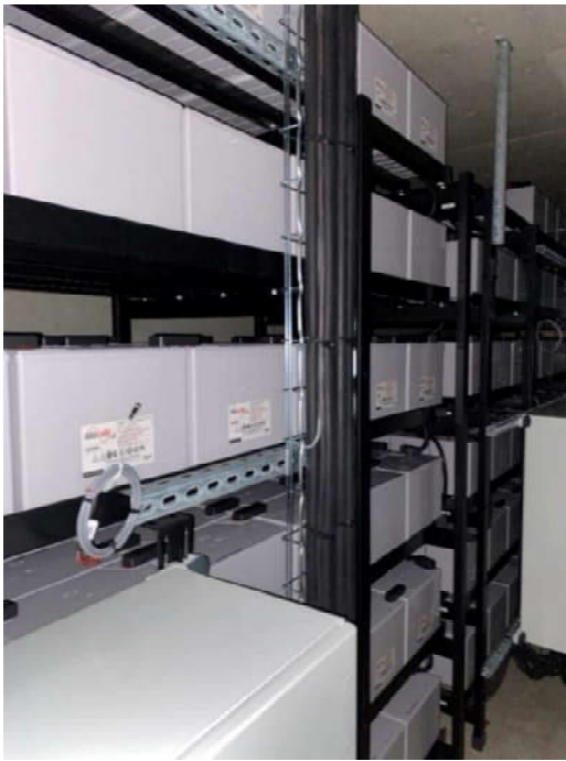
Photographie 11 : Local à batteries du type de celui impliqué dans l'incendie
