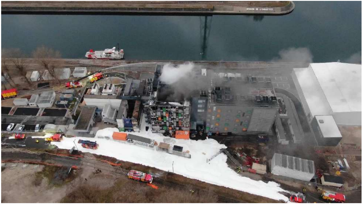
Photographie 15 : vue du site OVH à 06h47 le 10 mars 2021 (source SIS 67)
