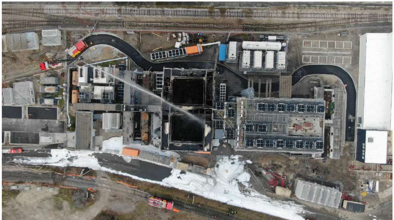
Photographie 16 : vue du site OVH à 9h30 le 10 mars 2021 (source SIS 67)
