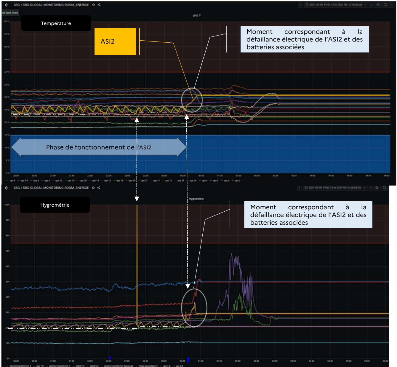
Figure 8 : Relevés de température et d'hygrométrie sur le site au niveau de l'ASI2 (source OVH)
