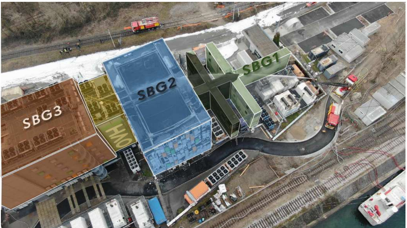
Photographie 9 : vue aérienne de SBG3 (en marron) SBG2 (en bleu) et SBG1 (en vert). SBG1, de taille plus petite que SBG2, a directement été exposé aux flux thermiques de l'incendie de SBG2. SBG3 séparé par une construction (en jaune) comprenant des escaliers et des espaces techniques et de taille comparable a été davantage protégé de l'incendie. En couleur sombre apparaît la zone de SBG1 touchée par l'incendie.
