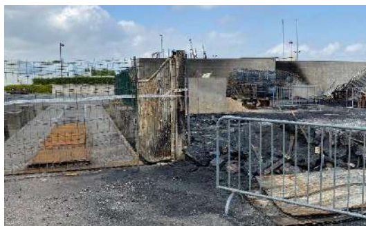
Photographie 12 : localisation du pont bascule
