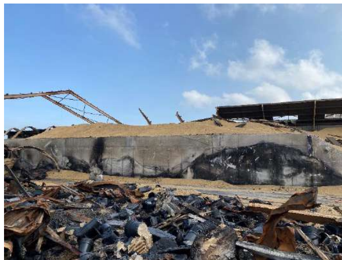
Photographie 4 : résistance au feu du mur béton
