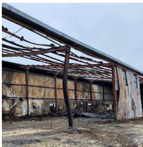
Figures 11 et 12 : Photo du hangar permettant de visualiser la déformation de la structure métallique
