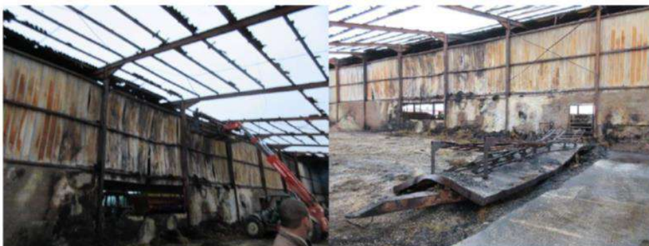
Figure 4 : Vue centre du hangar
