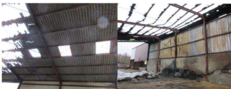
Figure 6 : toiture au-dessus du côté du stockage d'engrais
