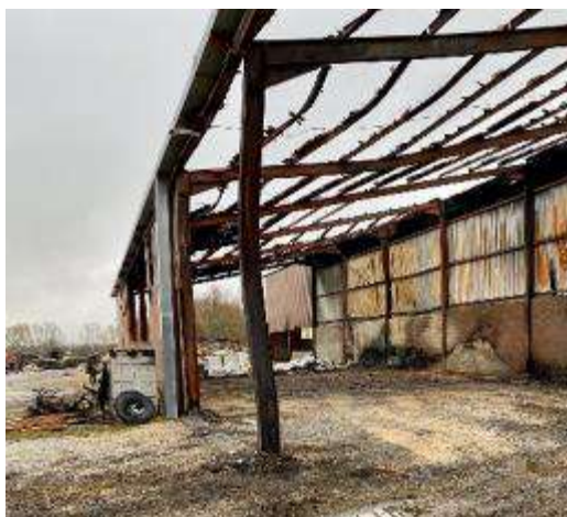
Figure 3 : Photo du hangar le 8/12/2020
