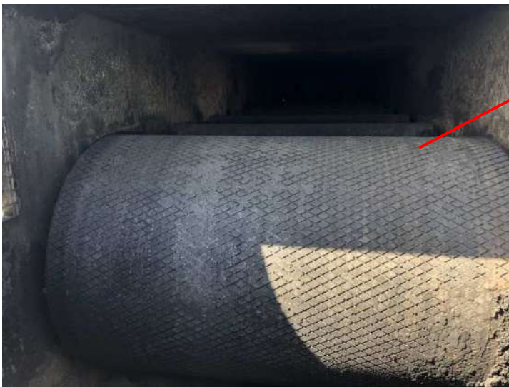
Figure 10 : Photo du rouleau de renvoi de la bande à bords situé en partie haute du silo 4000. La bande de roulement de cette dernière est en bon état.
