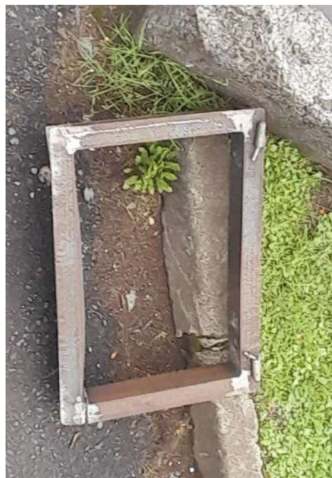
Photographies 2 et 3 : Photographies du cadre pré-percé en atelier. Les trous réalisés ne correspondent pas au plan de montage prévu par le schéma communiqué par l'exploitant.
