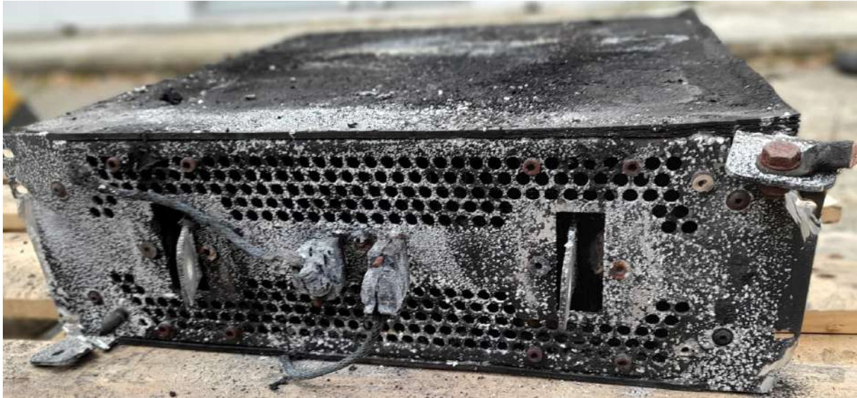
Figure 32: Prélèvement du module supercondensateurs
