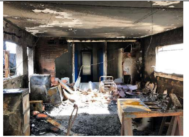
Photo 12 : Photo des bureaux ( Vue D )
