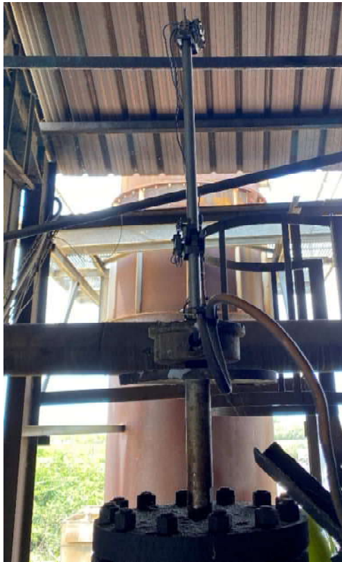
Figure 8 : contacts niveau haut, bas et très bas
