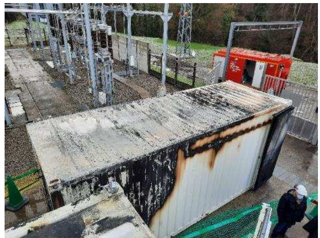
Photo 9 : Etat extérieur du container
