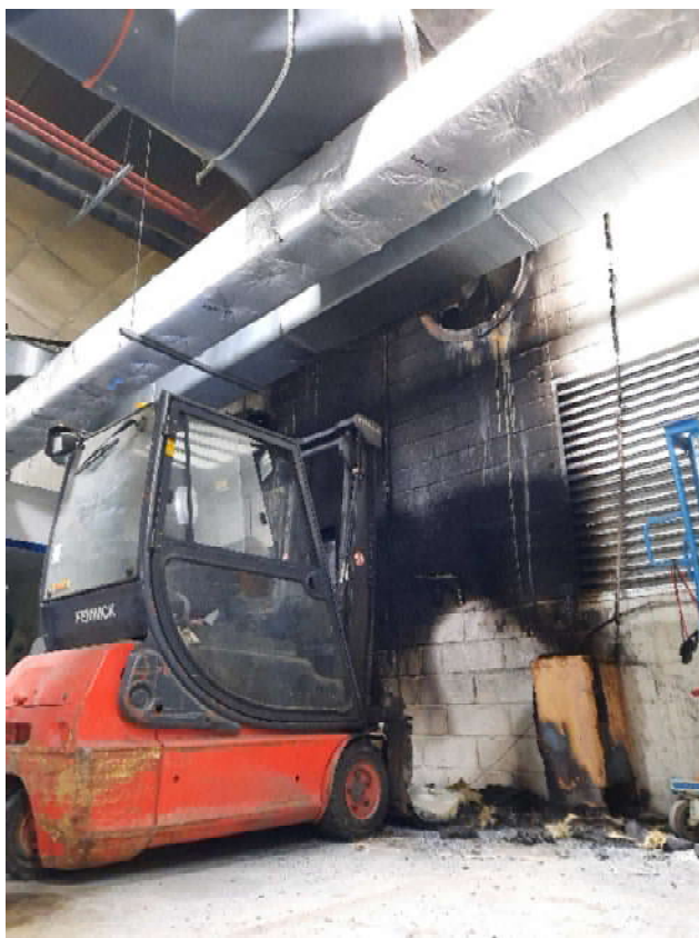
Photographie 4 : Vue du passage de l'émissaire d'aspiration des vapeurs à travers le mur coupe-feu.
