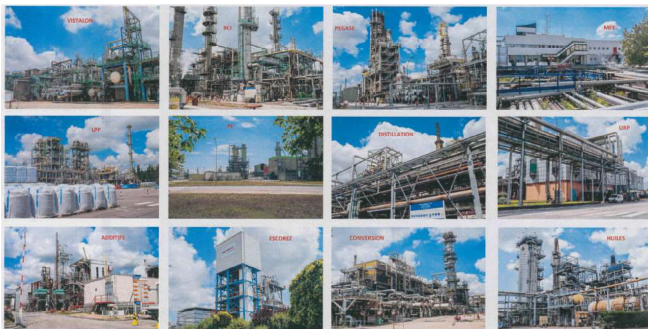
Photographie 1 : Villages de la plateforme de Port-Jérôme-sur-Seine (Source : Présentation ExxonMobil) De gauche à droite et de haut en bas : Vistalon, BCI, Pegase, MEE, LPP, PE, Distillation, URP, Additifs, Escorez, Conversion, Huiles
