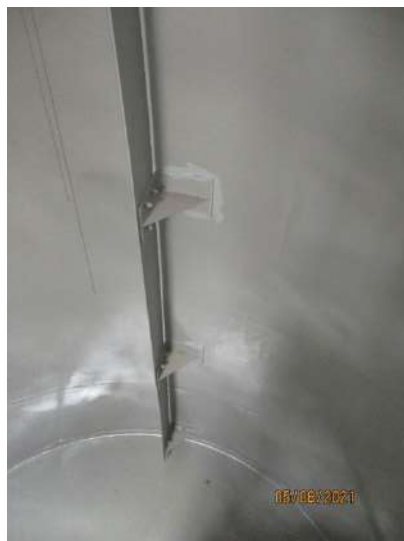
Figure 2. Photo de l'intérieur du réservoir R30 après pose de la résine et avant l'accident
