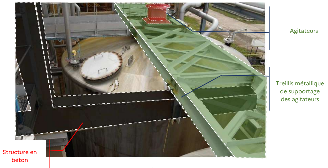
Figure 5 : Vue rapprochée des supportages des agitateurs
