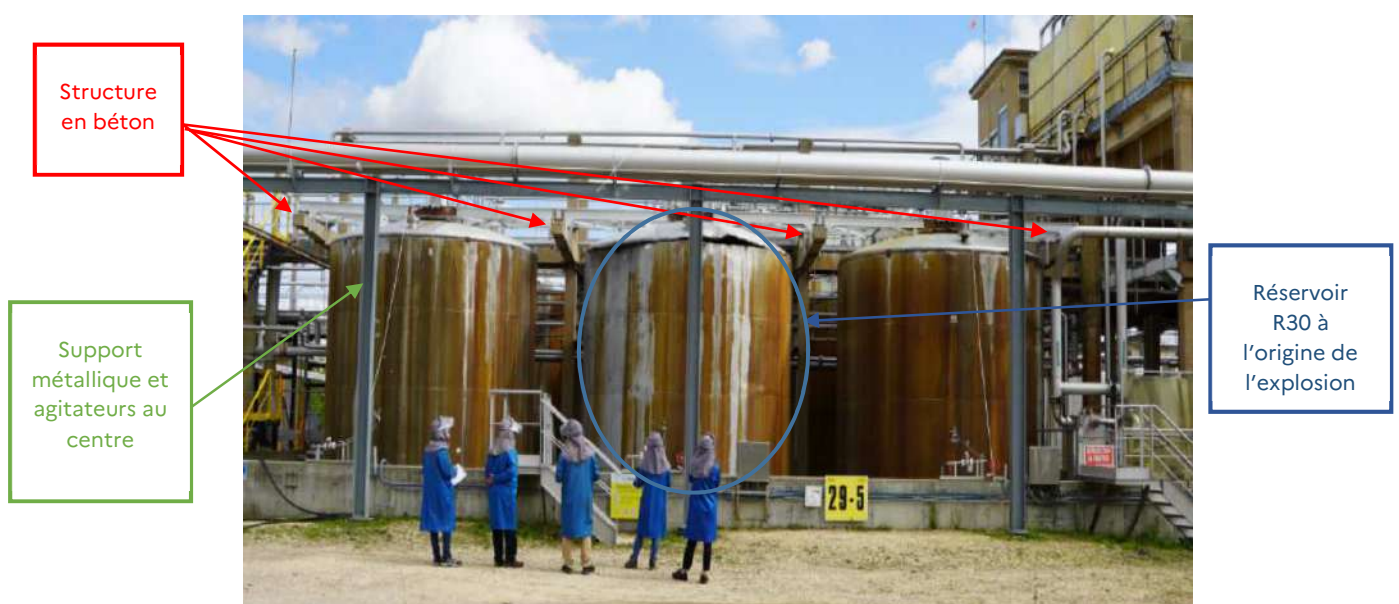
Figure 4 : Vue d'ensemble des réservoirs, des portiques en béton et du support métallique sur lequel sont fixés les agitateurs en partie haute (Source : MANUCO)
