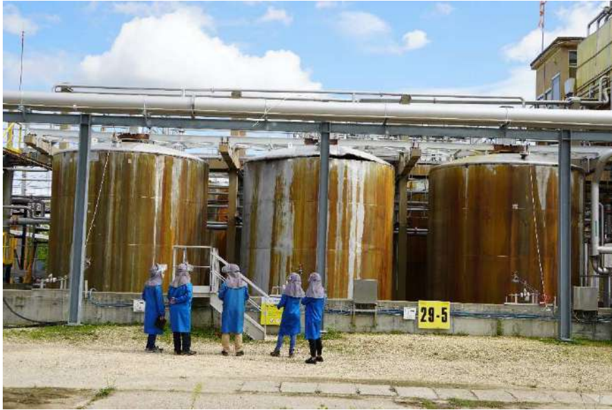
Photo 9 : Vue de la cuvette 29-5 après l'explosion
