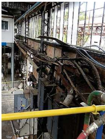
Figure 13 : Rupture de la canalisation DN150 reliant la cuve « eaux blanches » n°1 à l'épaisseur 3
