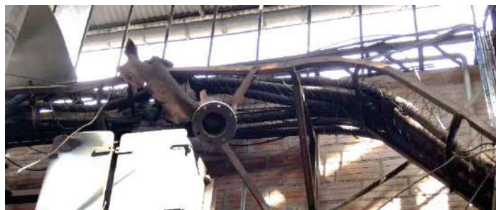
Figure 13 : Rupture de la canalisation DN150 reliant la cuve « eaux blanches » n°1 à l'épaisseur 3
