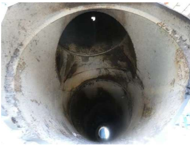
Photo 17 : Reste de nitrocellulose présent dans les canalisations de transport des eaux blanches
