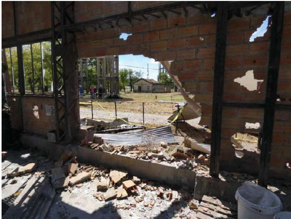
Figure 6 : Perforations du mur en briques
