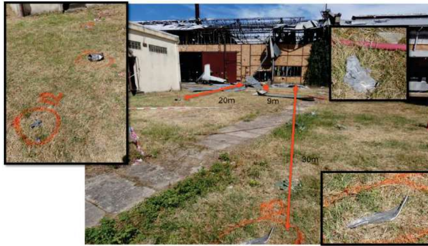
Figure 7 : Projection de fragments au Sud du bâtiment
