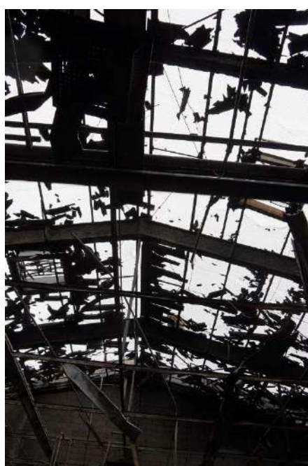
Photo 17 : Vue de la toiture au centre du bâtiment
