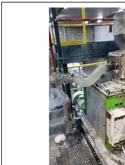
Photo 12 : Vue de l'une des gaines d'aspiration (boa) avant l'incendie (Source ARKEMA)
