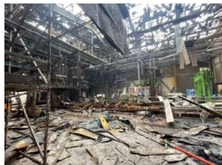
Photo 3 : Vue de l'intérieur du bâtiment soufflé par l'explosion
