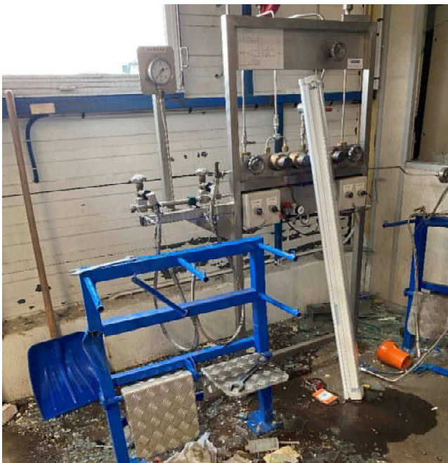
Figures 13 et 14 : rampe Basse Pression
