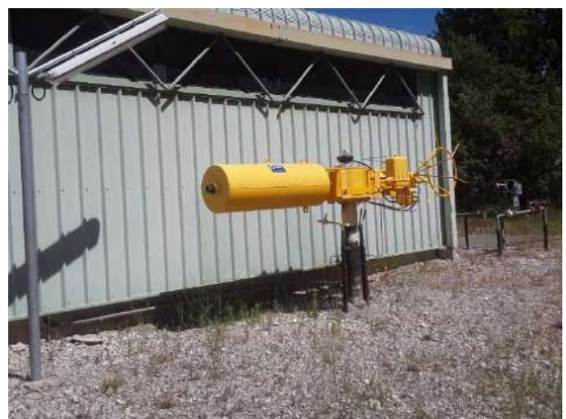
Figure 7 : Vanne d'isolement
