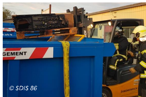
ARIA 54261 Solution d'immersion à la suite d'un emballement thermique d'une batterie Li-ion
